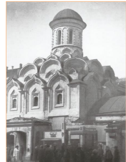
Отреставрированный Казанский собор перед разрушением. 1936 г.
